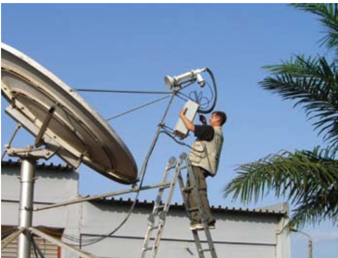
Установка станции в Гвинее Earth station installation in Guinea
