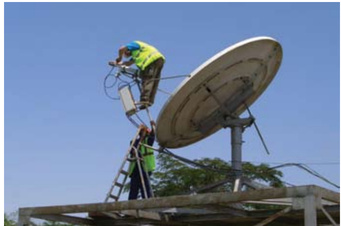
Установка станции в Нигерии Earth station construction in Nigeria
